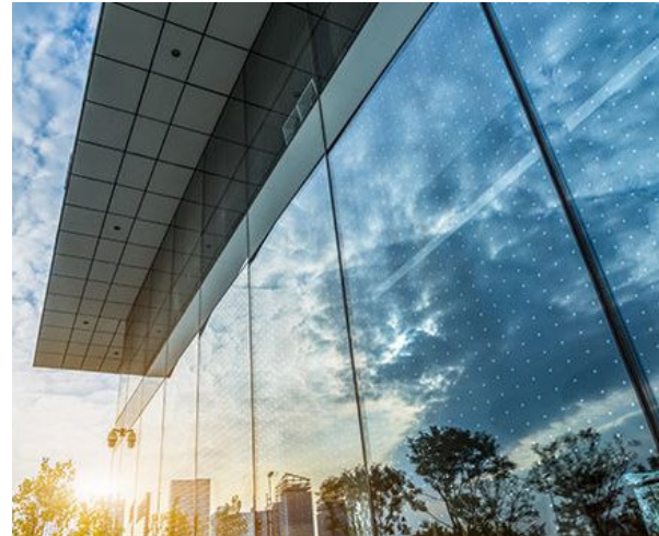
Abb. 17: Glasfassade mit Punktmuster, Quelle: SEEN AG
