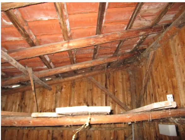
Abb. 9: Innenansicht des Schuppens mit Querbalken
