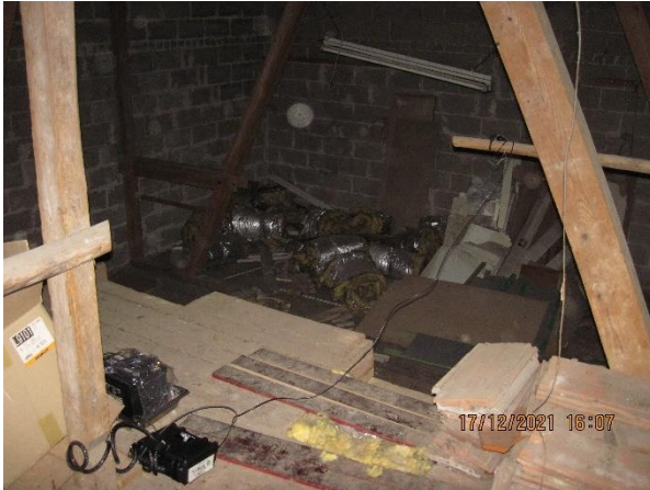
Abb. 13: Batlogger C in der Scheune
