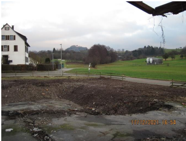
Abb. 9: Baugrube des ehemaligen Wohnhauses
