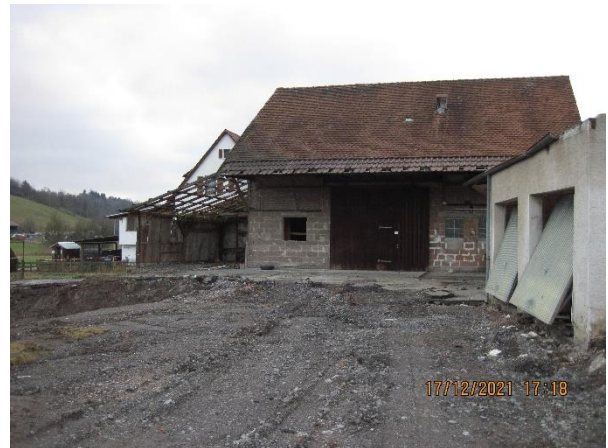
Abb. 10: Abzubrechende Scheune und Garage
