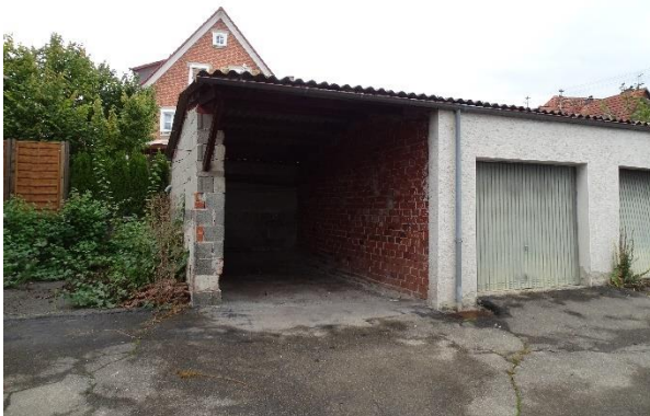
Abb. 5: Garage im Plangebiet
