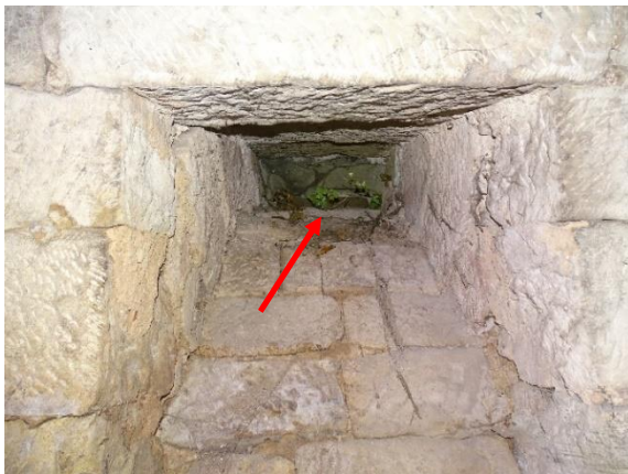
Abb. 16: Öffnung nach außen aus dem Gewölbekeller
