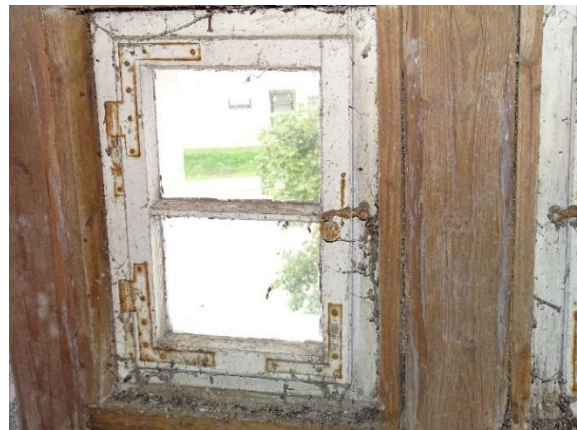
Abb. 17: Fenster auf dem Dachboden
