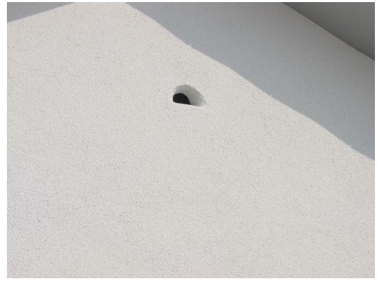
Abb. 23: Nist- und Einbaustein Typ 26 (Quelle: www.schwegler-natur.de )
