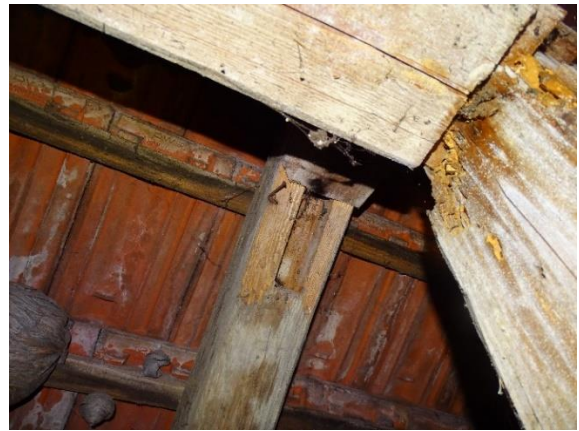
Abb. 8: Zapfenlöcher im Gebälk des Dachstuhls
