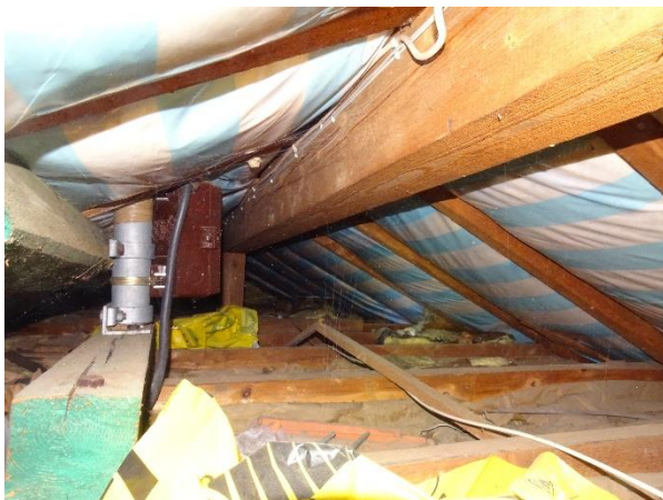
Abb. 8: Gedämmter Dachboden ohne Öffnungen nach außen
