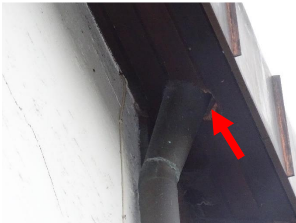
Abb. 6: Öffnung in Holzvertäfelung für das Regenrinnenfallrohr des Dachs (roter Pfeil)
