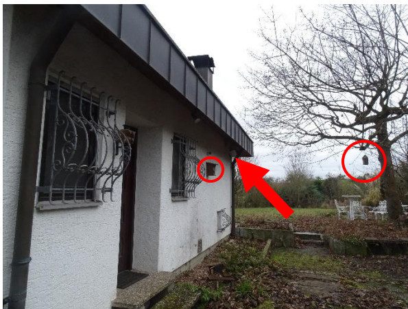
Abb. 2: Westseite des Gebäudes mit am Gebäude und am Baum angebrachten Höhlenbrüterkasten (rote Kreise) und Nischenbrüternisthilfe (roter Pfeil)
