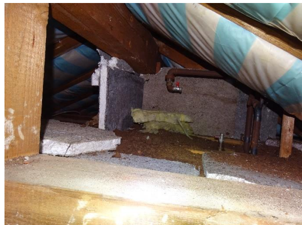
Abb. 9: Gedämmter Dachboden ohne Öffnungen nach außen
