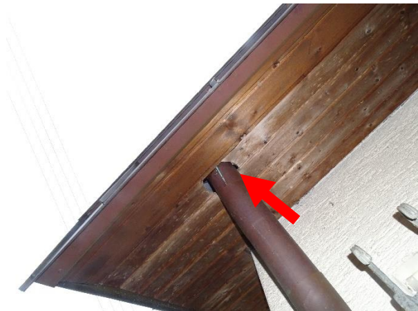
Abb. 7: Öffnung in Holzvertäfelung für das Regenrinnenfallrohr des Dachs (roter Pfeil)
