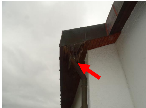
Abb. 5: Öffnung in Holzvertäfelung für das Regenrinnenfallrohr des Dachs (roter Pfeil)
