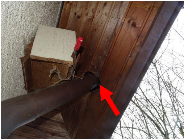
Abb. 4: Nischenbrüternisthilfe an der Südwestecke des Gebäudes mit Öffnung in Holzvertäfelung für das Regenrinnenfallrohr des Dachs (roter Pfeil)
