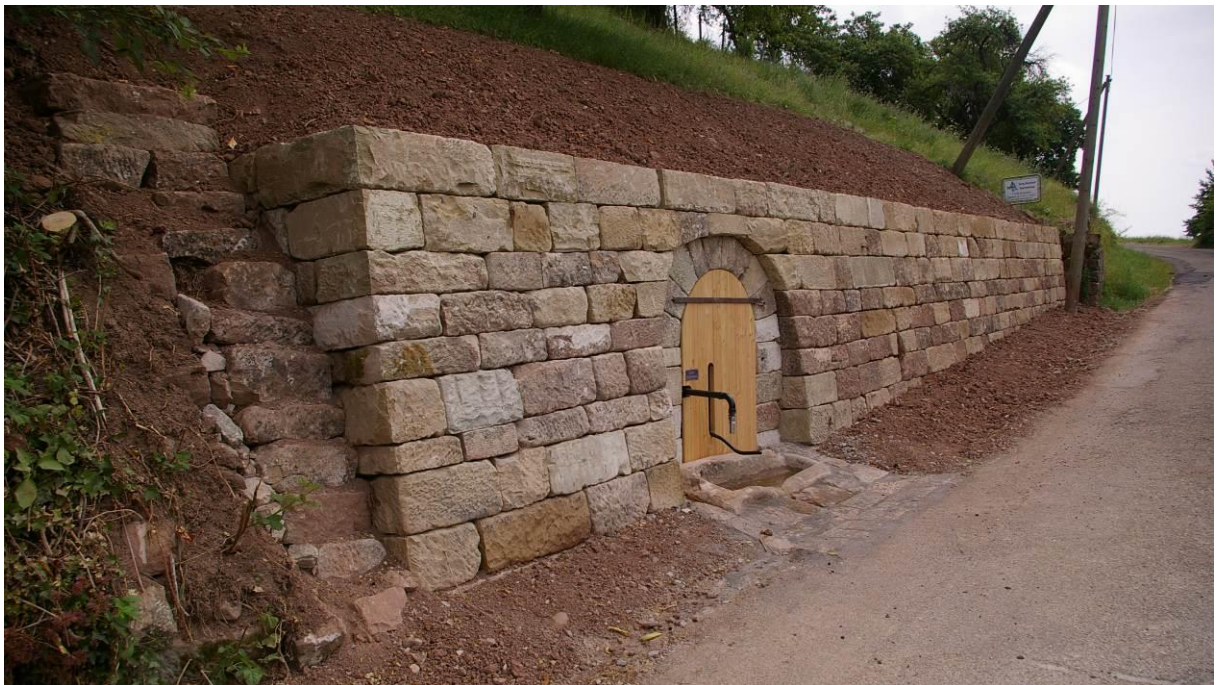
Abb. 13: Abschnitt 4 nach Fertigstellung
