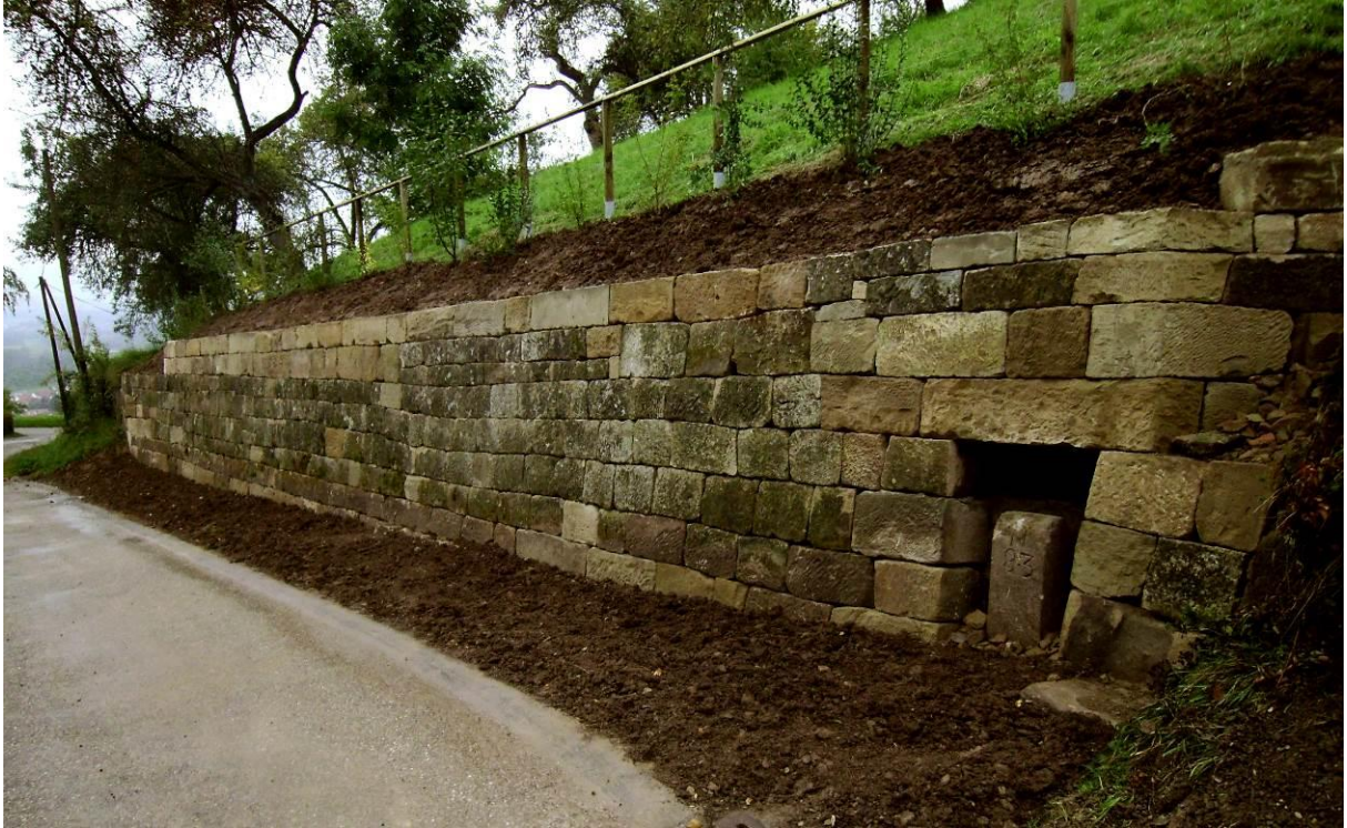
Abb. 14: Abschnitt 12 nach Fertigstellung
