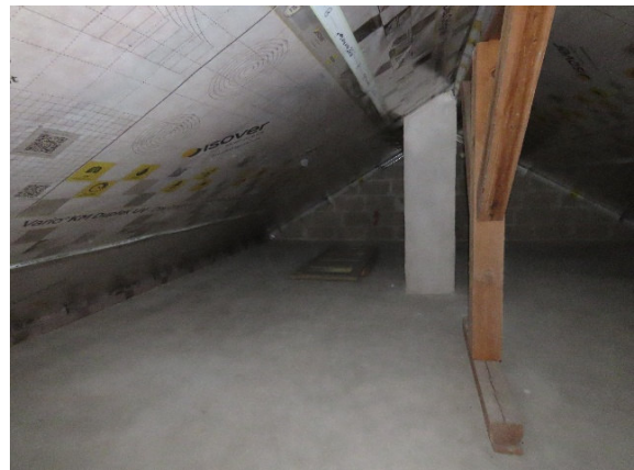
Abb. 4: Dachstuhl des Wohngebäudes
