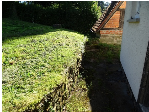
Abb. 8: Niedrige Mauer zwischen Wohngebäude und Garten, Blick nach Osten
