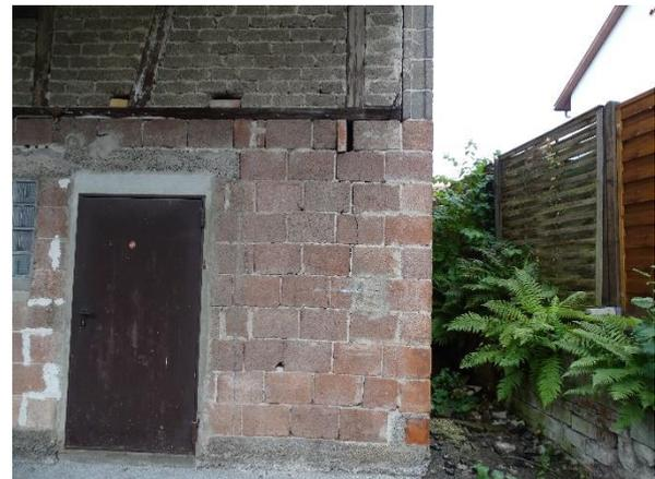
Abb. 6: Einflugöffnungen in Form von Spalten und zugängliche Hohlblocksteine im Bereich von Schadstellen an der Scheune
