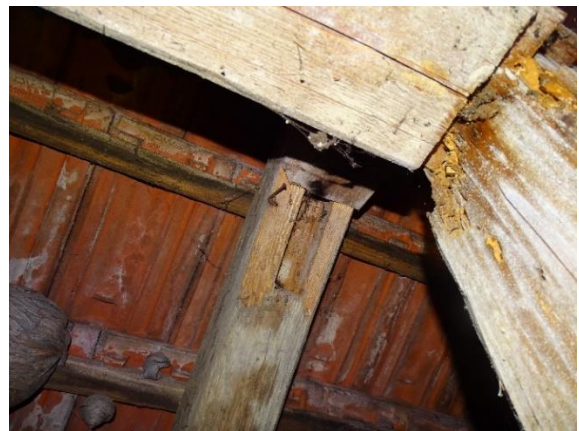
Abb. 8: Zapfenlöcher im Gebälk des Dachstuhls
